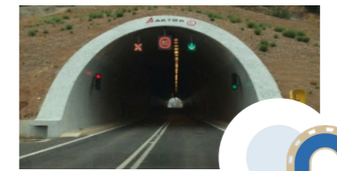
터널 · 도로 변형, 균열, 이상진동
