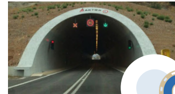
터널 · 도로 변형, 균열, 이상진동
