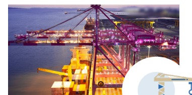
크레인 · 거더 변형, 이상진동
