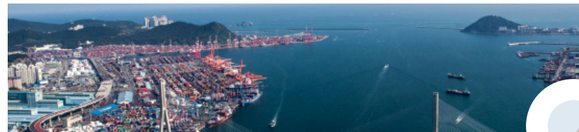
항만 변형, 균열, 이상진동
